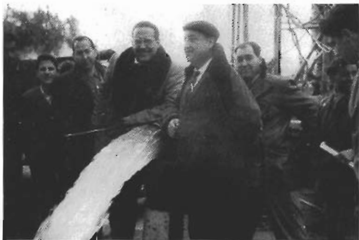
Inauguración de los pozos. Década de los 50
